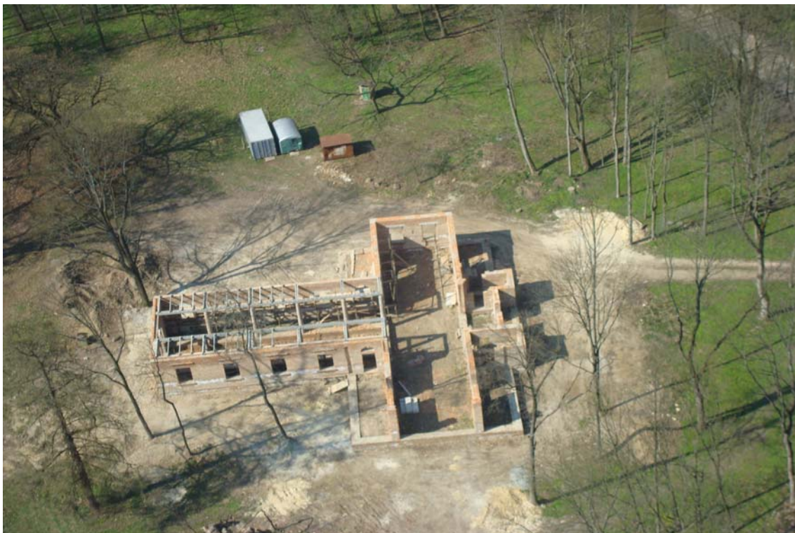
Рис. 2. Будівництво Танцювального павільйону (вигляд зверху, 2009 р.)
